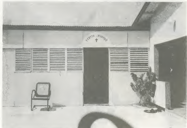
ENTRADA DI E SITIO DI ORACION NA MONSERRAT 6
